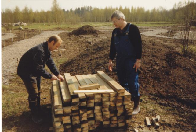
Ratojen perustukset tehtiin huolella. Työssä Erkki Nieminen ja Juhani Mykkänen
