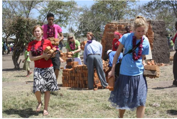
Tiilenkantoa koulua rakennettaessa 2008
